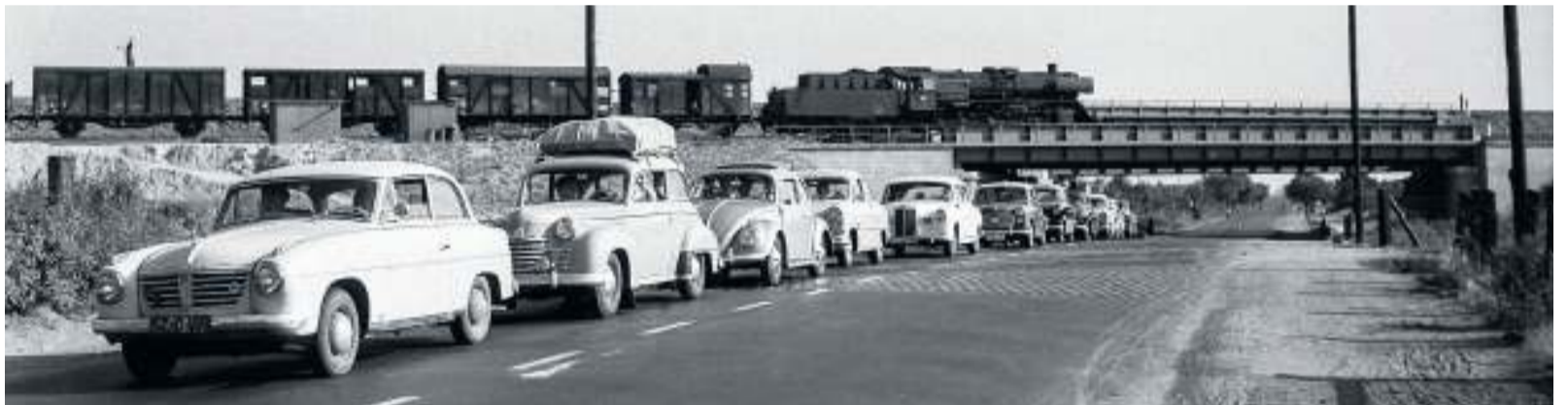
Wartende Autos vor dem Bahnübergang Alte Frankfurter Straße. Die Brücke steht immer noch. Am rechten Straßenrand befindet sich das Autohaus Willi Nies.
