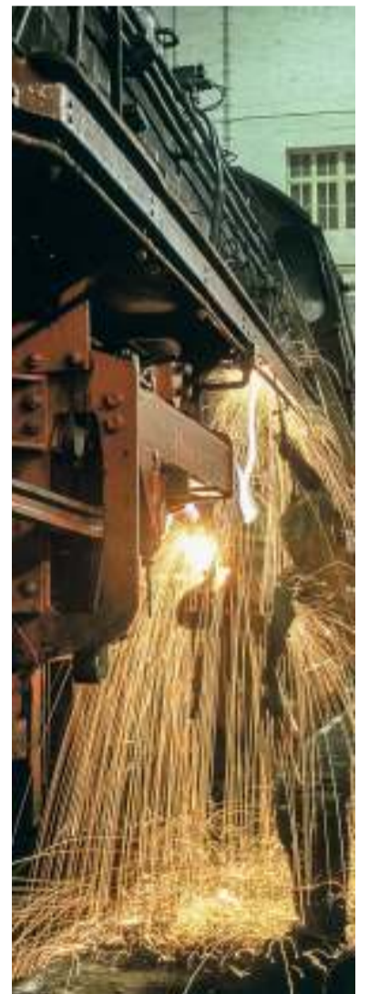
Lok-Reparatur: Zwei Schweißer stehen im Funkenregen.
